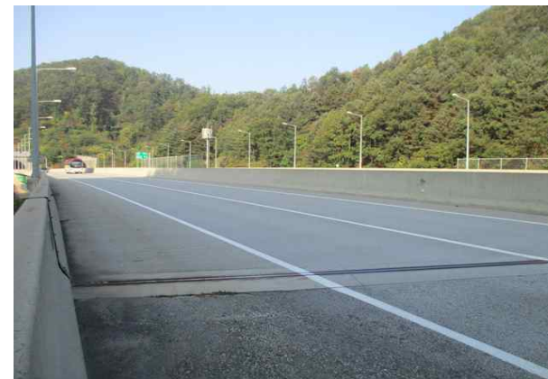
군자4교(양양) 상부 전경
