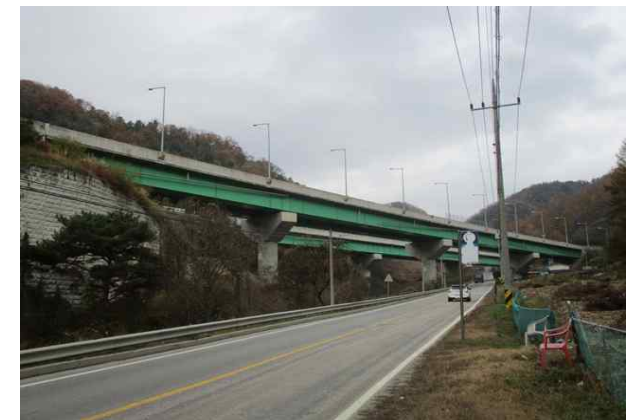
군자4교(양양) 측면 전경
