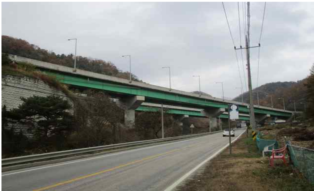
군자4교(양양) 측면 전경
