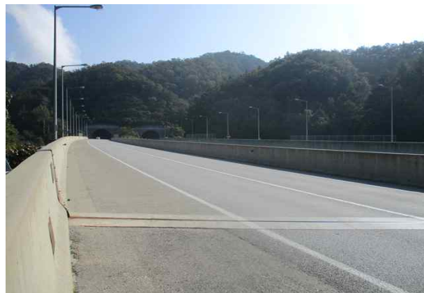
군자4교(서울) 상부 전경
